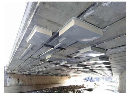
写真-1 CFRP プレート補強工法の実施例
