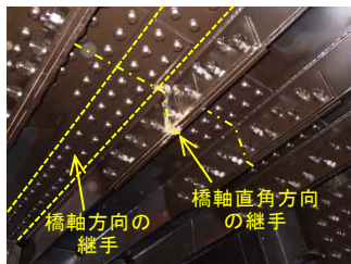
写真 3.1 継手部の漏水腐食 写真 3.2 腐食部拡大
