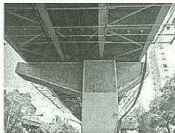
図-1 調査対象橋脚(表面保護撤去後)
