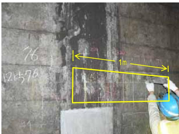
図-2 漏水箇所と調査範囲の例
