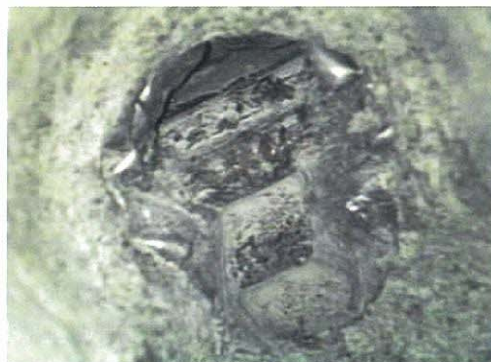
写真-6 グラウトが十分に充てんされている状況
