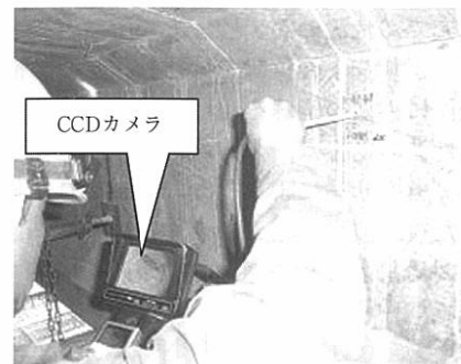
図-10 CCD カメラによる削孔内撮影事例
