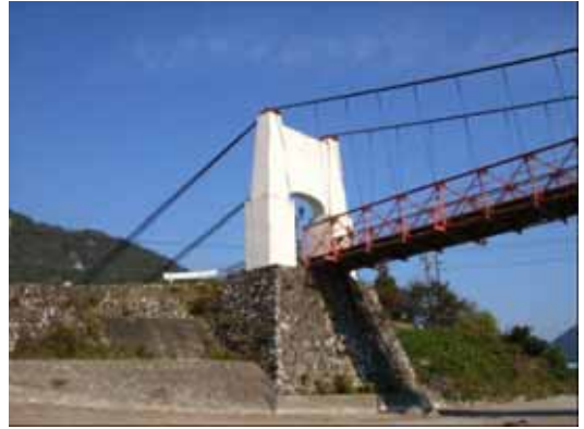
写真-1 右岸側主塔
