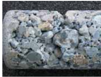
写真-4 右岸下流側主塔 で採取したコア
