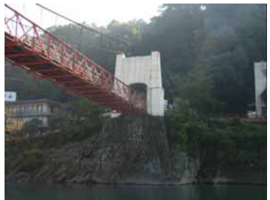
写真-2 左岸側主塔
