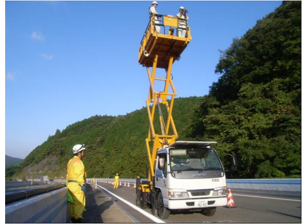
写真-7 赤外線法による上面の調査
