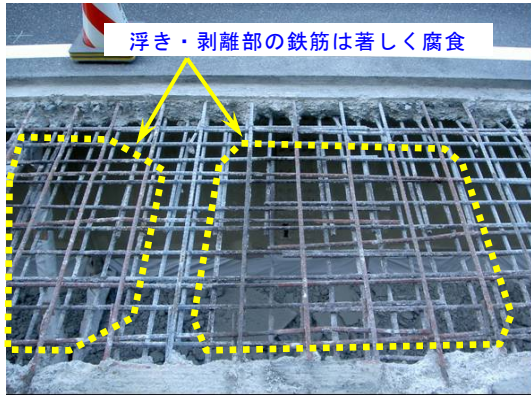
写真-5 剥離部周辺の腐食状況 (B橋)
