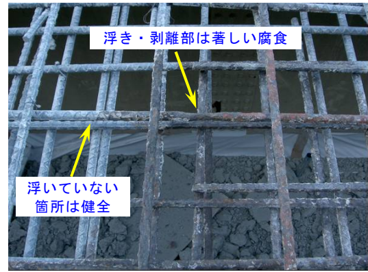
写真-5 剥離部周辺の腐食状況 (B橋)
