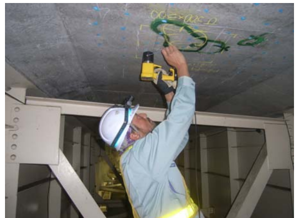
写真-8 床版下面からの弾性波法による調査
